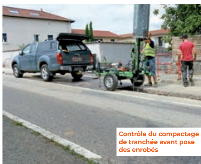
Reventin-Vaugris : Renouvellement du réseau d'eaux usées
