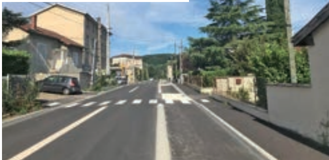
Aménagement d'une voie cyclable, Boulevard des Alpes à Vienne.
