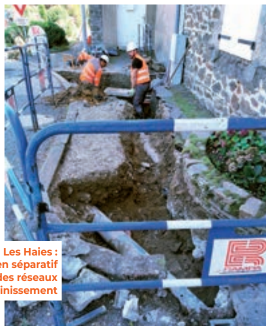
Chonas-l'Amballan : Redimensionnement et dévoiement du collecteur d'eaux pluviales
