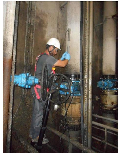
***Opération de contrôle d'un débitmètre***
